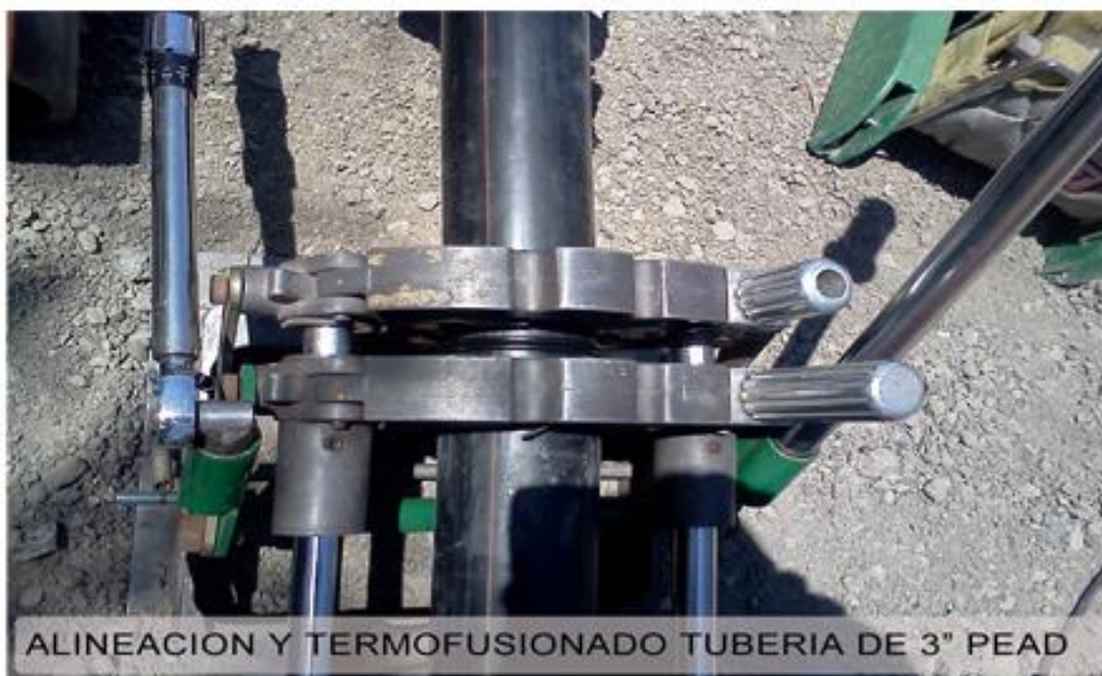
TERMOFUSIONADO DE TUBERIA PEAD
