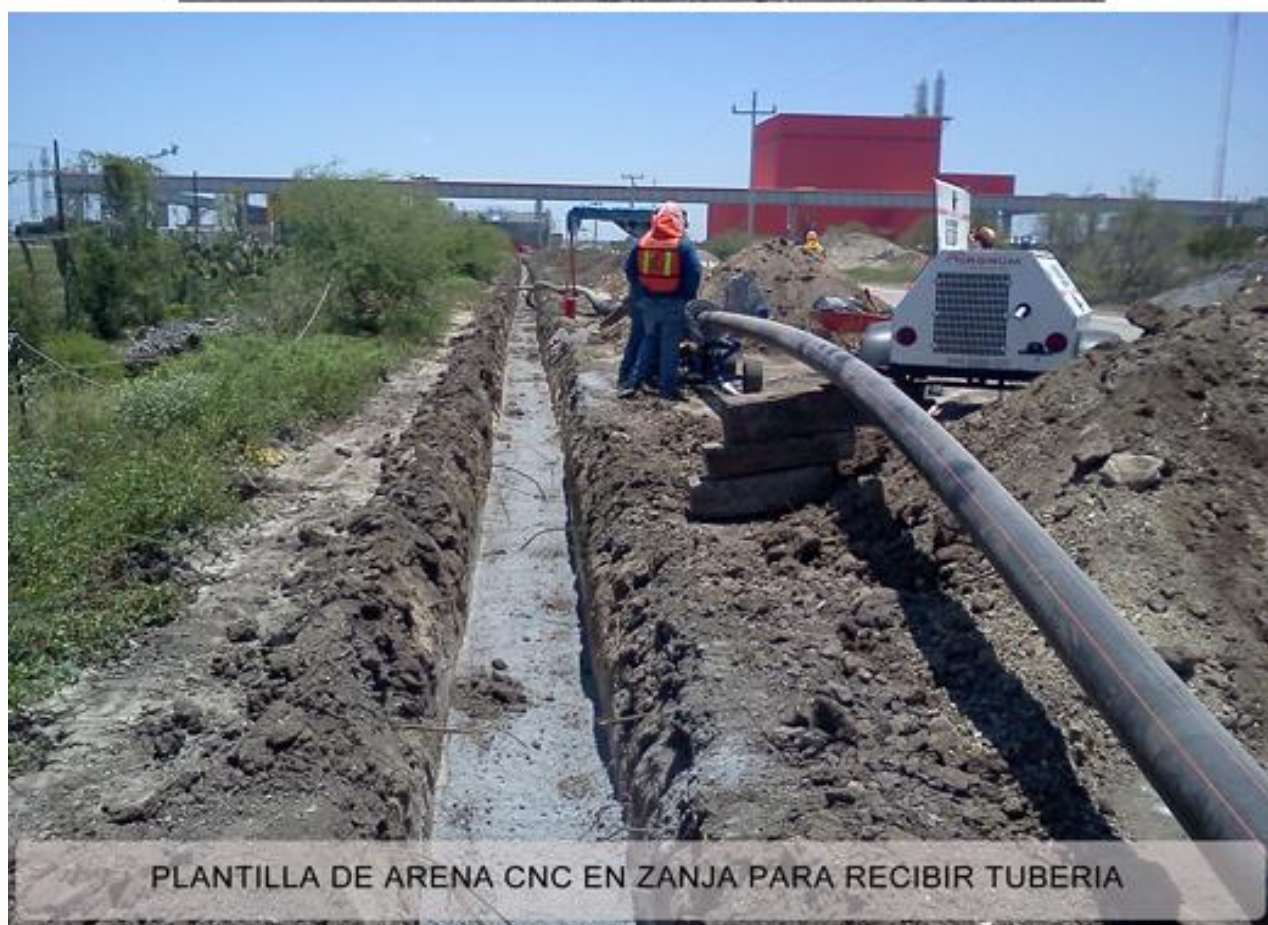
PLANTILLA DE ARENA CNC EN ZANJA PARA RECIBIR TUBERIA
