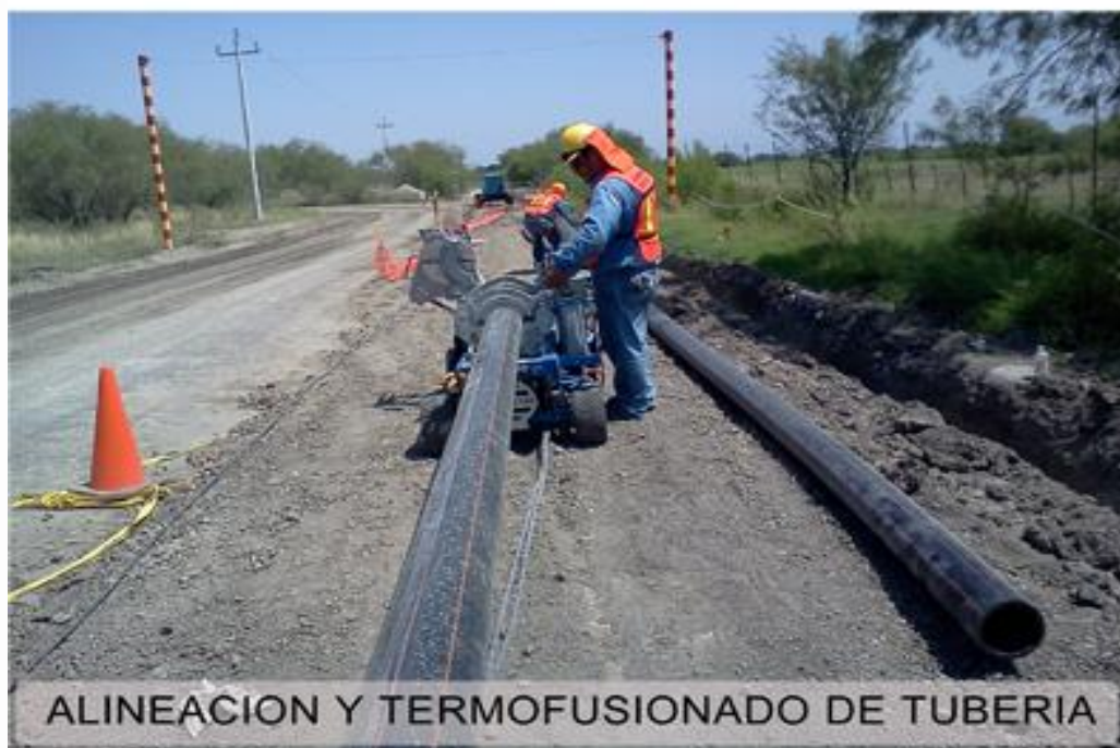
TERMOFUSIONADO DE TUBERIA DE 6" PEAD
