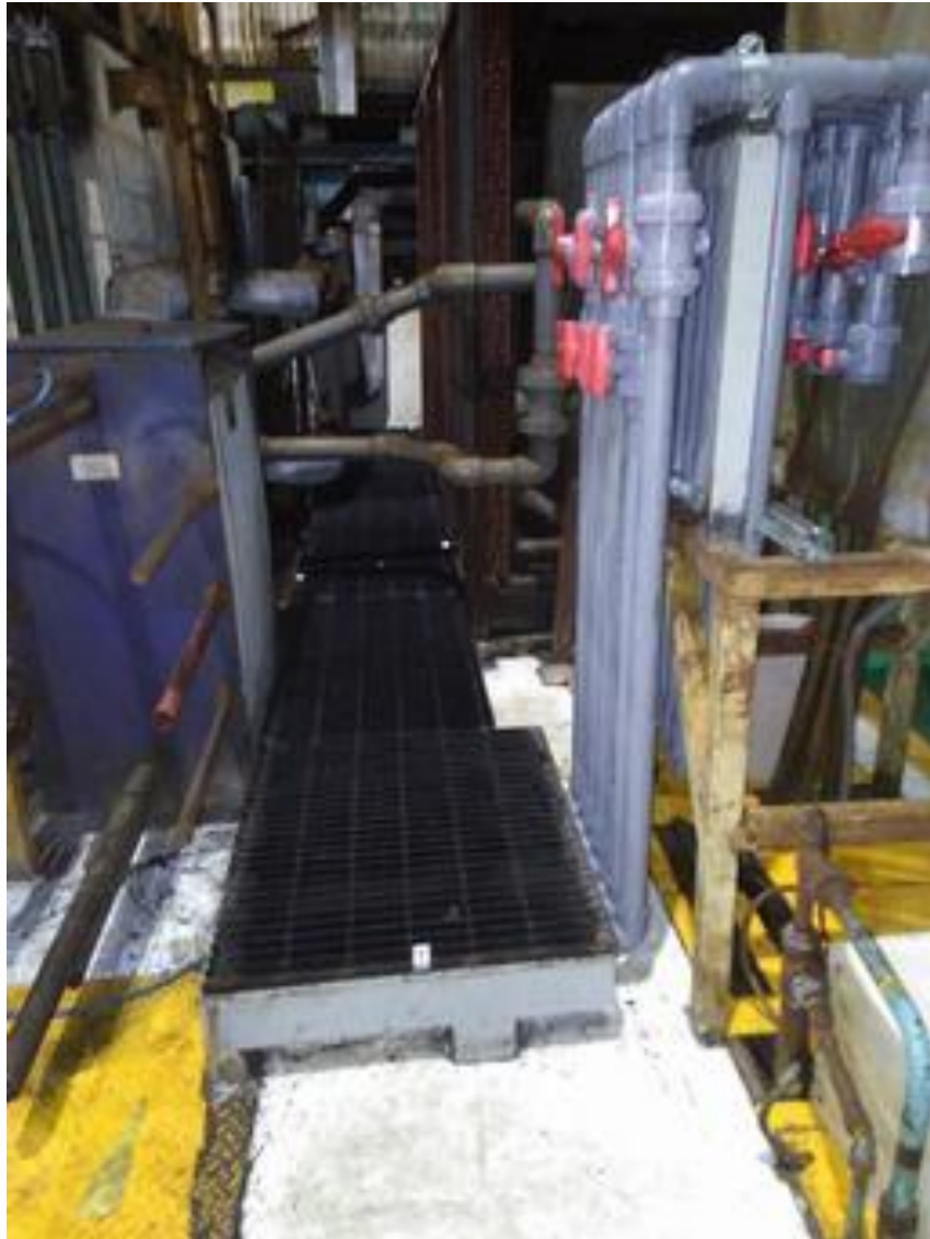
MONTAJE DE TUBERIA DE CPVC EN PLANTA CHURUBUSCO
