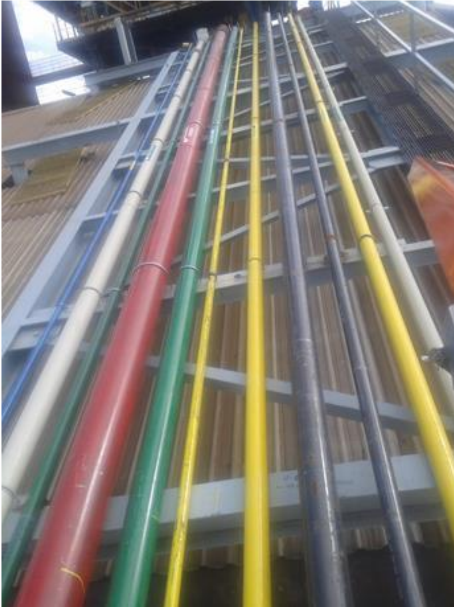
INSTALACION DE TUBERIA TERMOPLASTICA EN RACK
