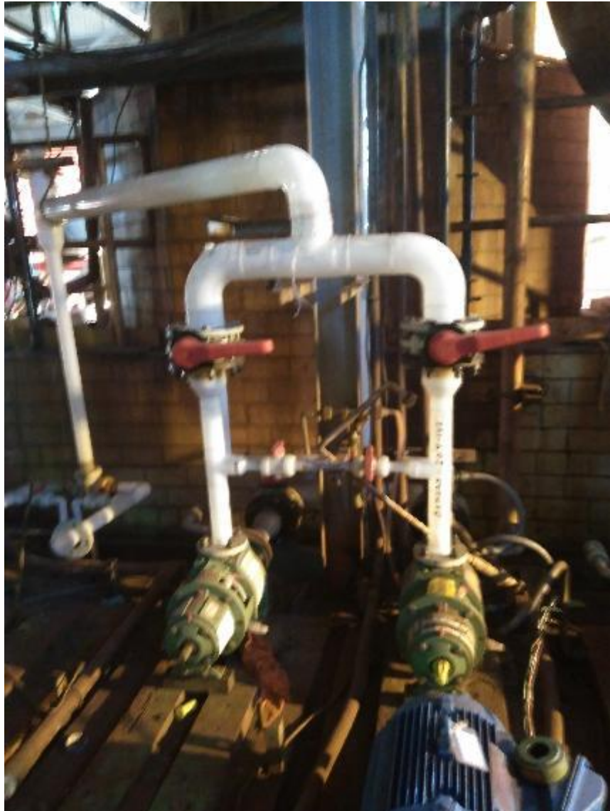
MONTAJE DE TUBERIA DE PVDF EN CAMPO
