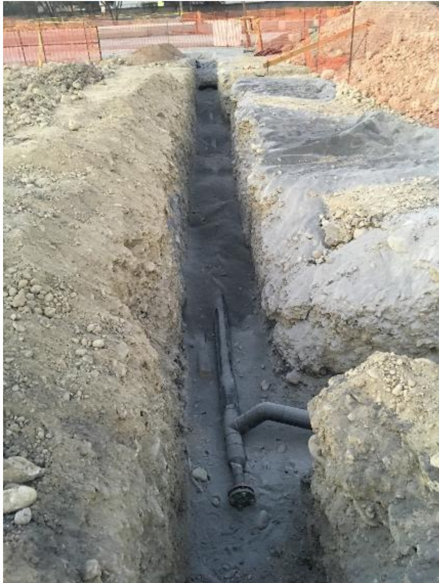
COLOCACION DE CAMA DE ARENA SOBRE TUBERIA
